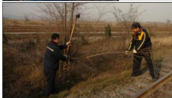
近日,运输部工讯段针对铁路沿线危树倾倒,影响行车安全的不利因素,组织员工对辖区沿线树木进行拉网式巡查,制定了危树修伐、清理制度,全面整治铁路沿线危树,截至11月底共修伐侵线危树100余株。图为员工正在修伐杂树。摄影报道 丁剑锋
