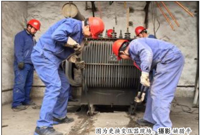
图为更换变压器现场。摄影 姚腊平
