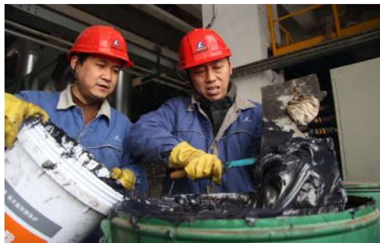
为贯彻落实两级职代会、党建会精神，近日，第一氧化铝厂沉降车间集中骨干力量加快快速分离洗涤系统的试车运行，确保早日投产并网运行。图为沉降车间员工为自动润滑系统加注润滑油。
