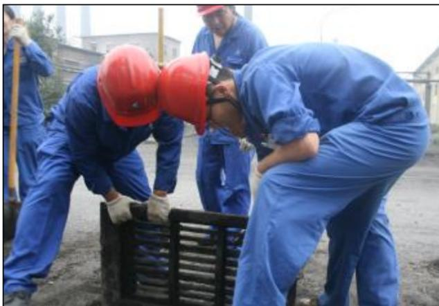
6月13日，水电分厂组织机关科室人员对氧化铝老系统厂区经一路、经二路、纬三路110个雨水篦子进行检查、清掏、疏通，确保汛期厂区道路畅通无阻。图为水电分厂员工检查清理雨水篦子。(米增霞)
